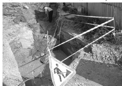
дороги очистили полностью до слоя старого асфальта, засыпали необходимым количеством щебня, проложили водосточные желобы, прорыли вместительный колодец. Теперь вода по проложенному канализационному пути будет поступать в специально проложенные безопасные участки ливневой канализации.
